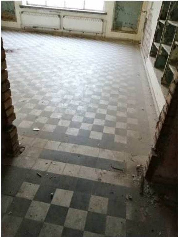
Patalpos 1-152 plytelių grindys, restauruojamos, stovis geras.
