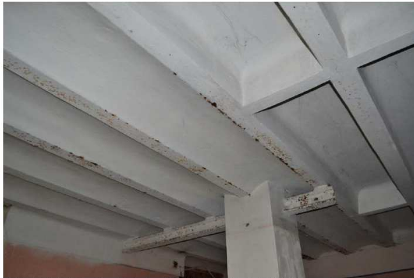
FF-22. Metalinių sijų g/b lygios SE-35.1 ir arkinės SE-35.2 perdangos fragmentai rūšio pat. R-34. Sijų paviršiuje ant metalo matyti korozijos žymės. Tinkas geros būklės.
