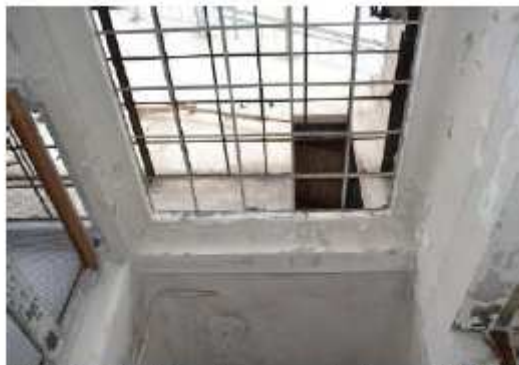
FF-86. Profiliuoto apvado tipas ST-38. Įrengtas centrinėje pastato dalyje, daugelyje II a. operacinės bloko patalpų aplink įstiklintas lubų plokštumas pagal 1929 m. pastato rekonstrukcijos projektą. Saugomas keltuvas SE-49, vertikalus užapvalintas sienos kampas SE-60.
