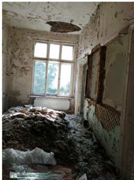
Vidinės sienos langai. Atstatomi, Restauruojami
