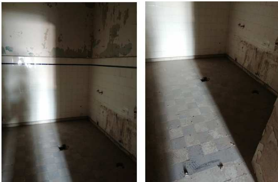
Restauruojamos grindų ir sienų plytelės Patalpoje 1-142
