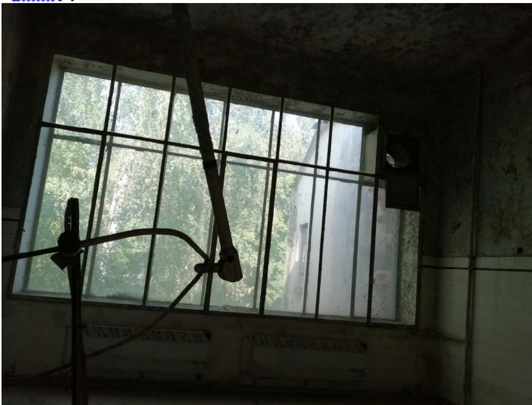
Restauruojamas langas patalpoje 1-147, metalas valomas, dažomas, keičiami stiklai.
