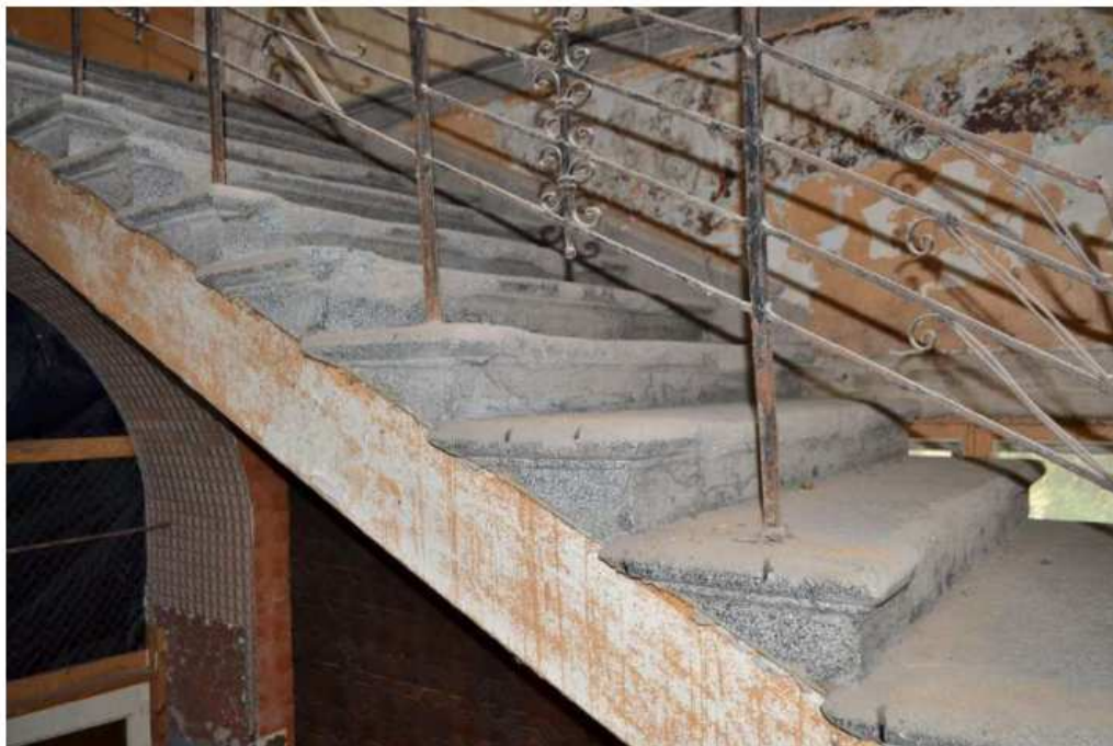
FF-65. Centrinųjų laiptų SE-42 viršutinis maršas. Teraco pakopų profilis nuo rūsio iki II a. vienodas. Pakopų ir aikštelių būklė bloga. Metalinio ažuрино turėklo SE-43 ornamentika nuo rūsio iki II a. taip pat nekinta. Būklė patenkinama, tačiau yra sulankstyty, prarastų elementų, matosi korozijos poveikis. Turėklo medinis porankis sunaikintas.
