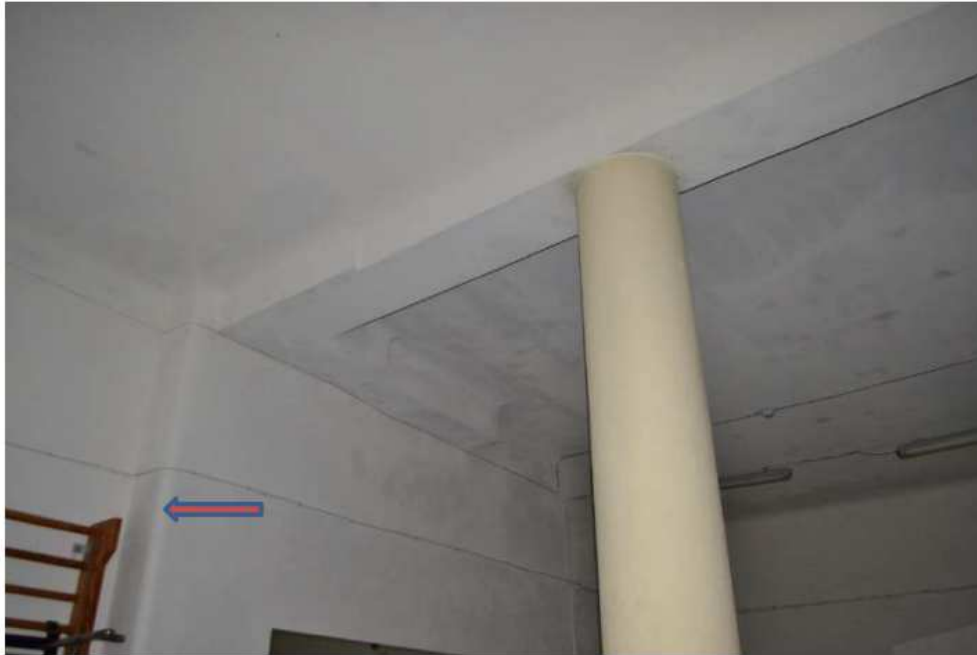
FF-33. Pat. 1-41 fragmentas. Patalpa po remonto pritaikyta treniruoklių salei. Rekomenduojama saugoti: kapitalinių sienų mūrą SE-1; plokščią g/b perdangą SE-35; lubų ir sienos sandūros užapvalinto kampo tipą ST-38.1; lubų ir sienų apdailos lygaus tinko tipą ST-39; kolonas SE-59; vertikalų užapvalintą sienos kampą SE-60.
