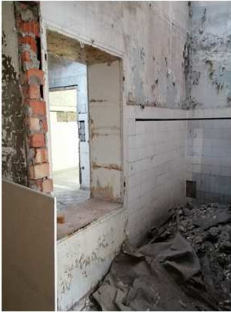
Patalpa 1-149. Restauruojamas vidaus Langas, restauruojamos sieninės ir grindų plytelės
