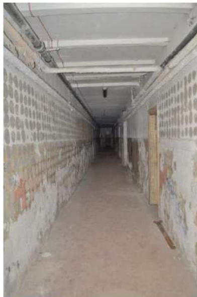
FF-13. Koridoriaus pat. R-2 vaizdas iš pastato centro į vakarų pusę. Grindys betoninės, ant sienų likę tarybinių plytelių apdailos likučiai. Rekomenduojama saugoti dalyje koridoriaus esantį metalinių sijų lygios g/b perdangos fragmentą SE-35.1.
