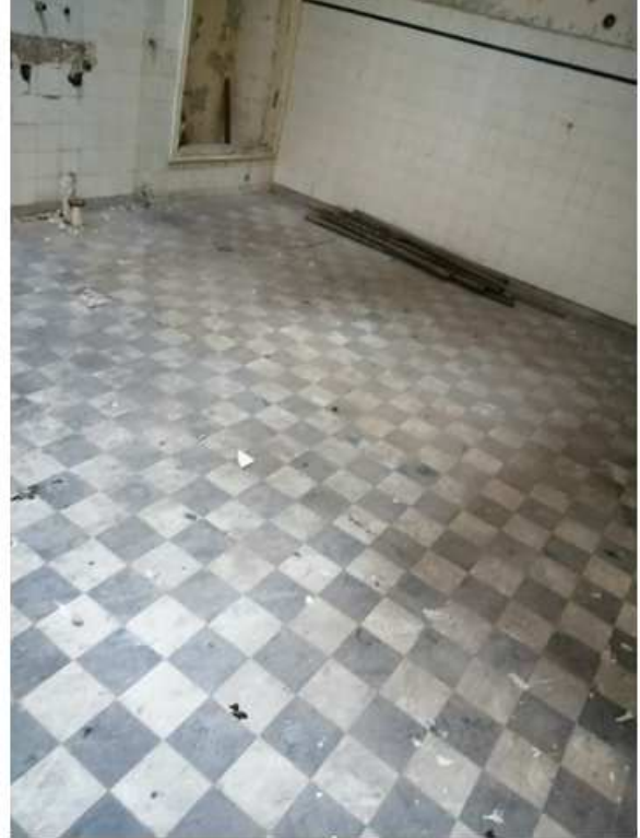
patalpos Nr.1-153 grindys. Restauruojamos, Stovis geras. Sienų plytelės restauruojamos. Stovis patenkinamas.
