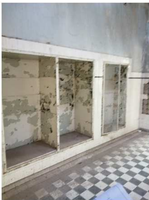
Patalpa nr.1-148, restauruojamos sieninės pintos, sienų ir grindų plytelės
