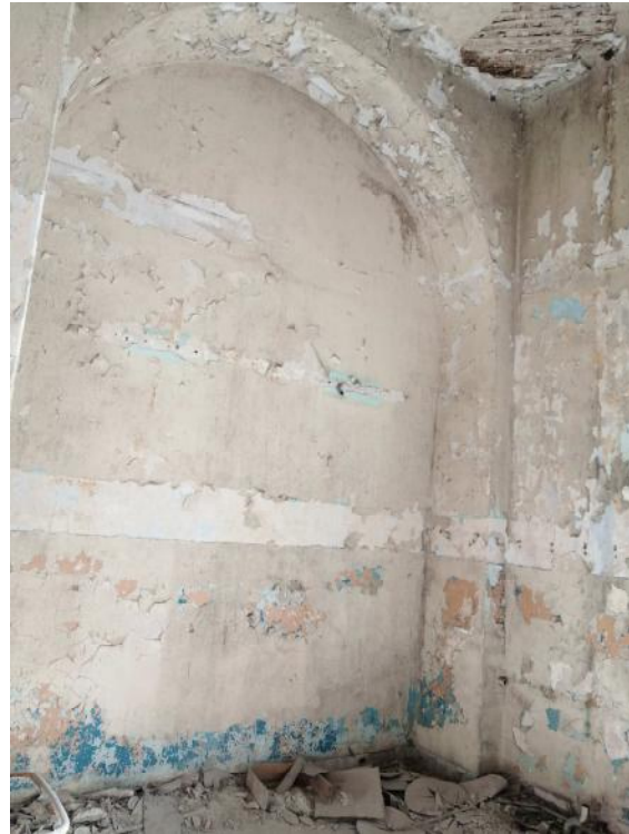
Sąraminės arkos. Restauruojamos.
