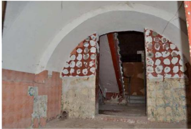
FF-1. Vaizdas iš rūšio pat. R-1 į vakarų pusę ir centrinę laiptinę. 19 a. buvęs koridorius pertvaromis sudalintas į atskiras patalpas. Grindys betoninės, blogos būklės. Sienų paviršiai išklijuoti tarybinėmis keraminėmis plytelėmis, kurios nuo drėgmės krenta. Skliauto tinkas geros būklės. Patalpa nešildoma. Rekomenduojama saugoti: kapitalinių sienų mūrą SE-1; durų angas SE-15; cilindrinio skliauto perdangą SE-33 su lunetėmis; pusės apskritimo formos arkas SE-37; lubų ir sienų apdailos lygaus tinko tipą ST-39.
