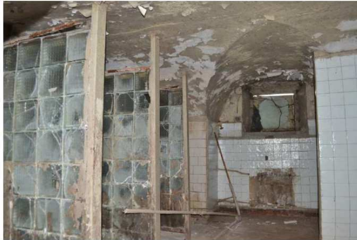
FF-16. Vaizdas pat. R-11 į vakarinę sieną su lango anga SE-17. Skliautuotoje patalpoje tarybiniais metais įrengta dušo patalpa, sienos išklijuotos plytelėmis. Langas užsandarintas. Tinko būklė labai bloga. Rekomenduojama saugoti: kapitalinių sienų mūrą SE-1; langų angas SE-17; cilindrinio skliauto perdangą SE-33 su lunetėmis; lubų ir sienų apdailos lygaus tinko tipą ST-39.
