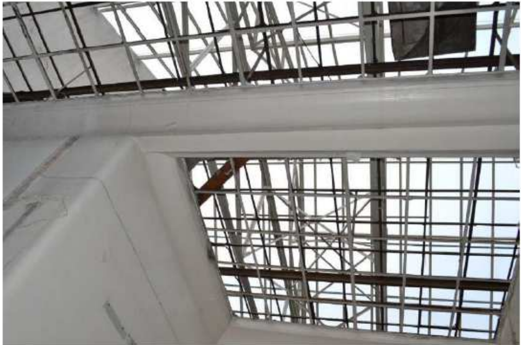
FF-88. Stiklo plokštumos lubų plafono vaizdas koridoriuje prie lifto, žvelgiant į šiaurės pusę link operacinių bloko.
