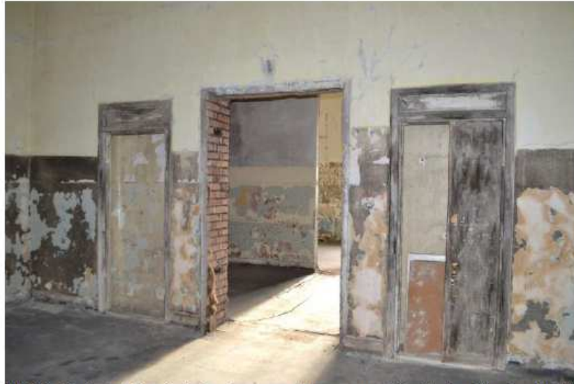
FF-83. Pat. 1-156 pietinė siena su durų anga SE-15 ir nišomis SE-52 sieninėms spintoms. Analogiškai įrengtos ir kitos šiaurinės pastato pusės patalpos – buv. palatos. Sieninių nišų vidaus paviršiai tinkuoti, kampai užapvalinti. Nišose likę išmontuotų vandentiekio ir nuotekų vamzdyno bei prietaisų tvirtinimo žymės. Spintos buvę su durelėmis. Durų angos autentiškos, angokraščiuose likę mediniai tašeliai staktų tvirtinimui. Durų glėfai kapitalinėse sienose galimai buvo uždengti mediniais skydais, kadangi yra netinkuoti.
