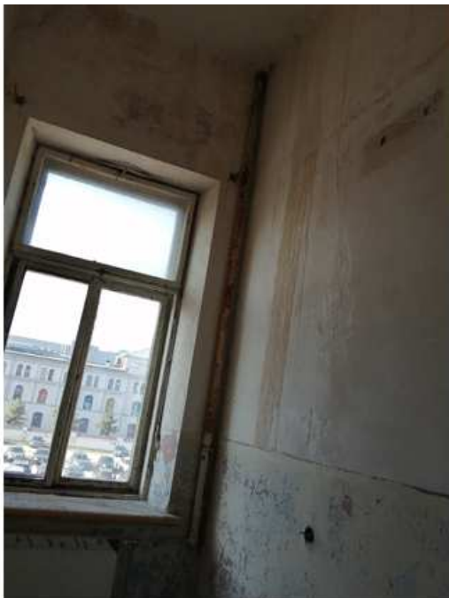
Saugoma palangė ir siūlomas saugoti lietaus kanalizacijos vamzdis nuo stogo, pravedtas per vidaus patalpas.
