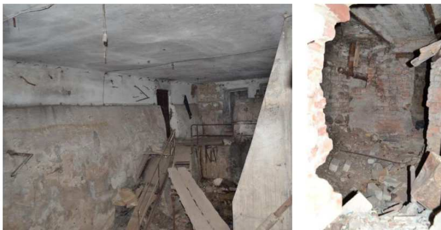
FF-14. Patalpa R-32 – buv. katilinė su įgilintomis grindimis. Patalpa apleista, priversta šiukšlių, nešildoma, nevėdinama. Rekomenduojama saugoti kapitalinių sienų mūrą SE-1; lygią g/b perdangą SE-35; durų angą (vidaus ir išorės) SE-15; lango angą SE-17.
