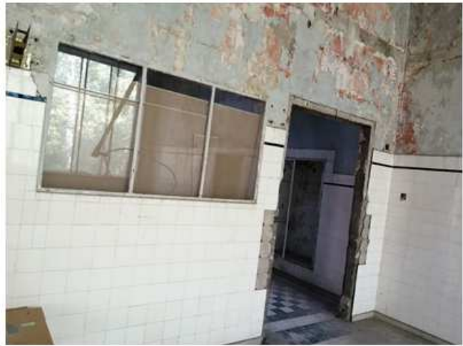
Vaizdas iš patalpos 1-149 į patalpą 1-147 Restauruojamas langas, sienų plytelės
