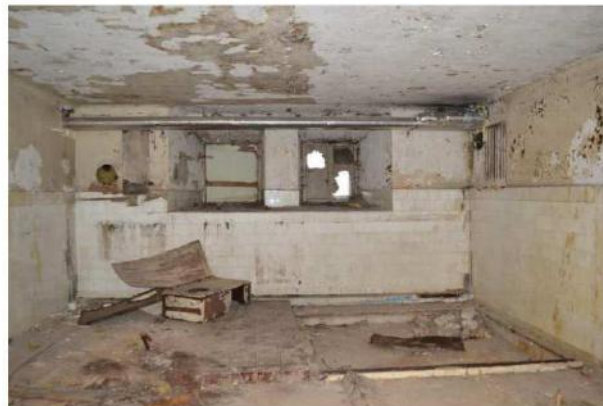
FF-10. Pat. R-16 vaizdas į šiaurės pusę. Patalpa apleista, vienas langas užkaltas.
