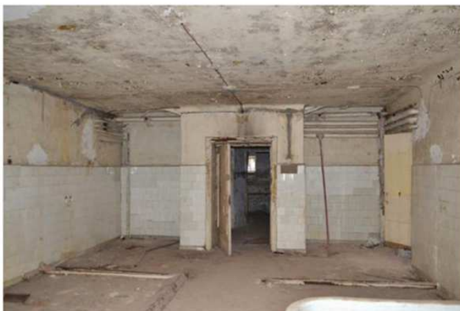
FF-11. Pat. R-16 vaizdas į pietų pusę su tambūru SE-62 ir durų angimis SE-15. Rekomenduojama saugoti: kapitalinių sienų mūrą SE-1; durų angas SE-15; g/b perdangą SE-35; lubų ir sienos sandūros užapvalinto kampo tipą ST-38.1; lubų ir sienų apdailos lygaus tinko tipą ST-39; tambūrą SE-62.
