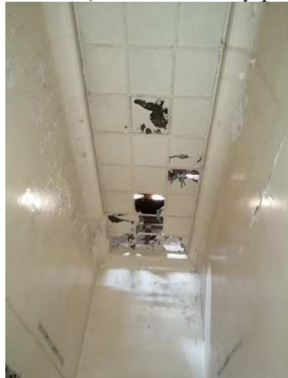
Restauruojamos stiklinės lubos. Metalų rėmą tikrinti atskirai. Restauruojamos, išstiklinamos stiklo paketais (tik po konstruktoriaus patikrinimo, ar metalo rėmas atlaikys paketais).
