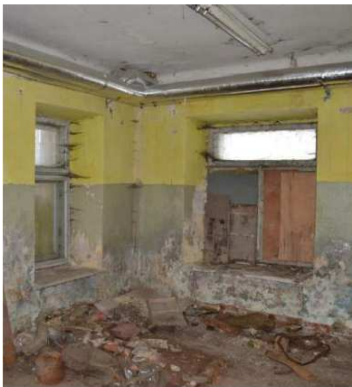
FF-25. Patalpa R-26 centriname šiauriniame rizalite, įrengtame pagal 1929 m. rekonstrukcijos projektą.
