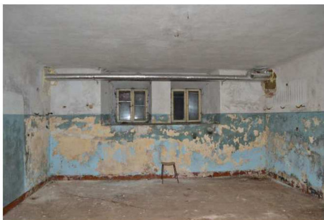
FF-23. Pat. R-14 vaizdas. Sieną su langais šiaurinėje sienoje. Jie žemi, įrengti aukštai. Rekomenduojama saugoti: kapitalinių sienų mūrą SE-1; langų angas SE-17; g/b perdangą SE-35; lubų ir sienos sandūros užapvalinto kampo tipą ST-38.1; lubų ir sienų apdailos lygaus tinko tipą ST-39.
